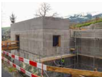
Rohbau Reservoir Dorf
